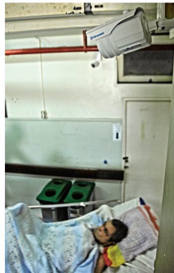
O equipamento grava a partir da detecção de movimento, dia e noite, no local escolhido para a filmagem
