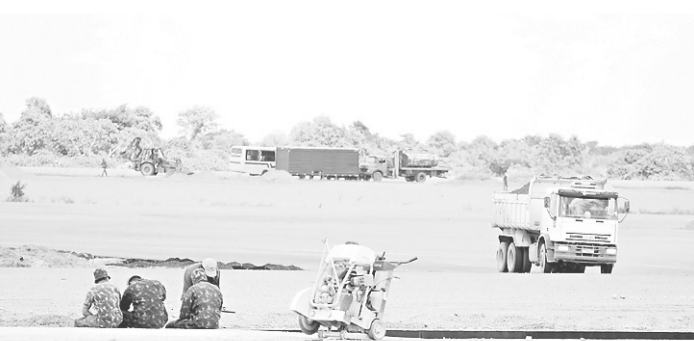
► Pista, tocada pelo Batalhão de Engenharia, deve ser liberada até novembro
