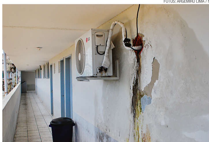
▶ Rachaduras e infiltrações comprometem a estrutura do prédio
