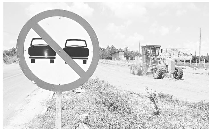
► Máquina começa a abrir acesso para o terminal a partir da BR-406
