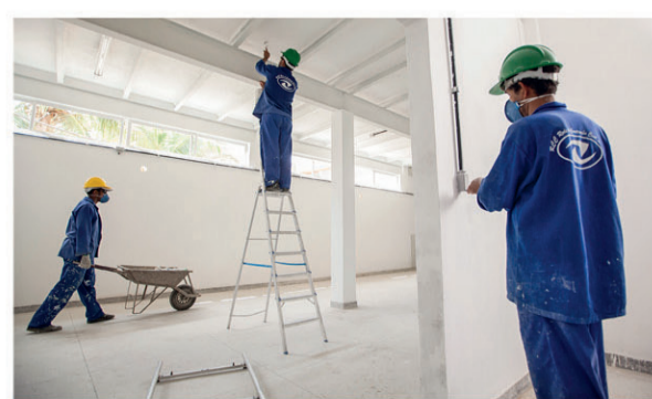
REFORMA DO HOSPITAL GISELDA TRIGUEIRO
