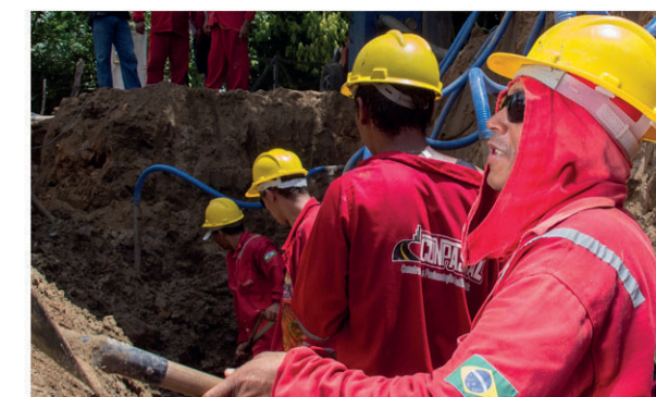
ESGOTAMENTO SANITÁRIO TIBAU DO SUL
