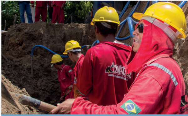
ESGOTAMENTO SANITÁRIO TIBAU DO SUL
