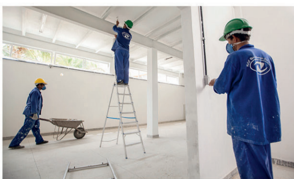
REFORMA DO HOSPITAL GISELDA TRIGUEIRO
