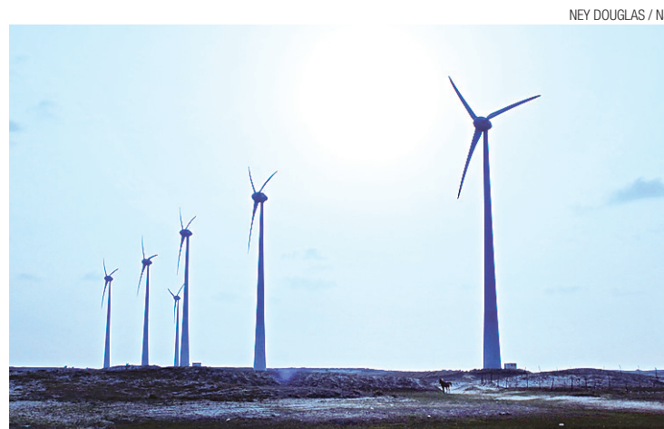
► Parques estão prontos, mas não têm como transmitir a energia
