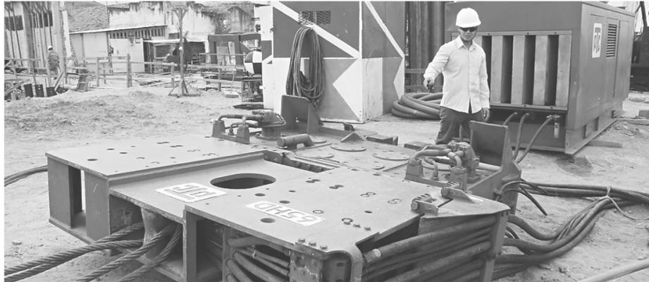
► Engenheiro Rommel Souza explica que abalos são causados pelo martelo vibratório, utilizado para fincar as estacas no solo
