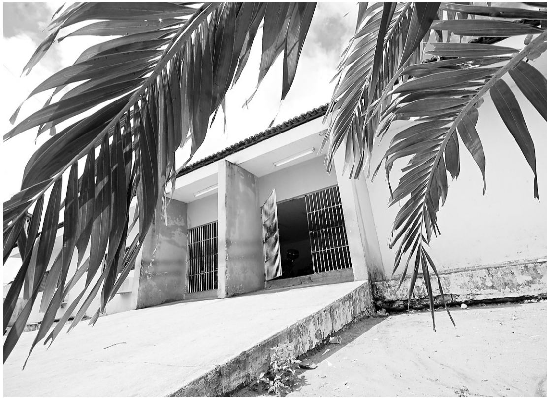
▶ Presídio Provisório Raimundo Nonato Fernandes, localizado na Zona Norte de Natal
