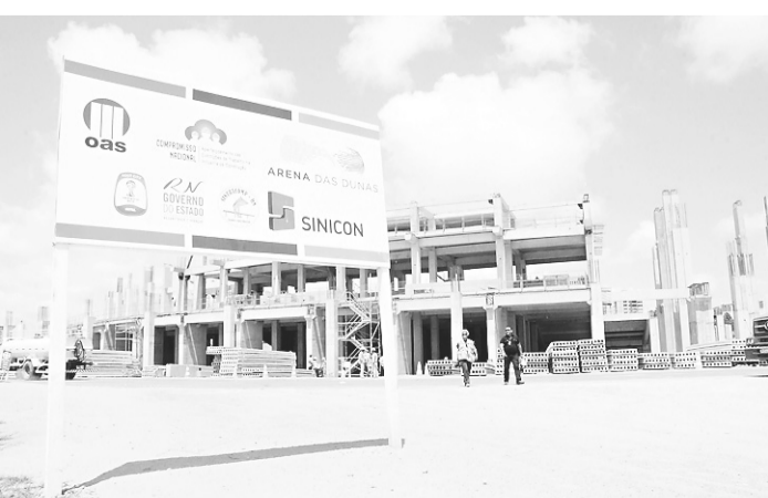
▶ Placa sinaliza que faltam 370 dias para o término das obras do estádio
