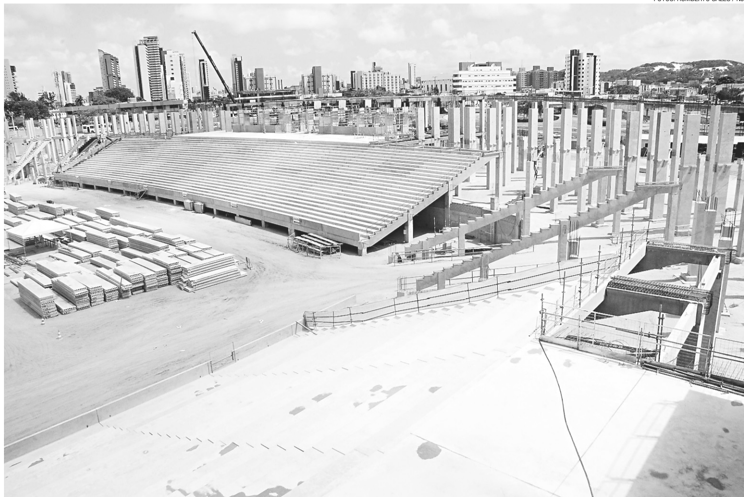
▶ Até agora a obra do novo estádio consumiu 46 mil metros cúbicos de concreto, 18 mil toneladas de cimento e 3,8 mil toneladas de aço
