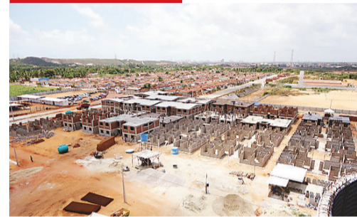
► Conjunto em construção no Leningrado, em Natal
