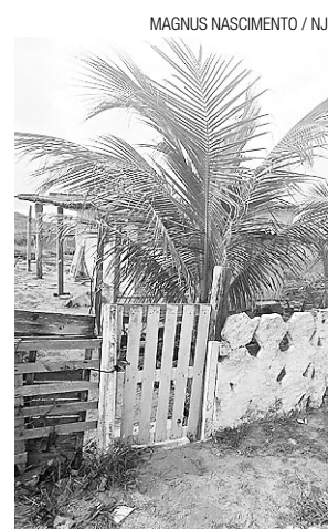
▶ Imóvel construído e ocupado irregularmente pertence ao governo
