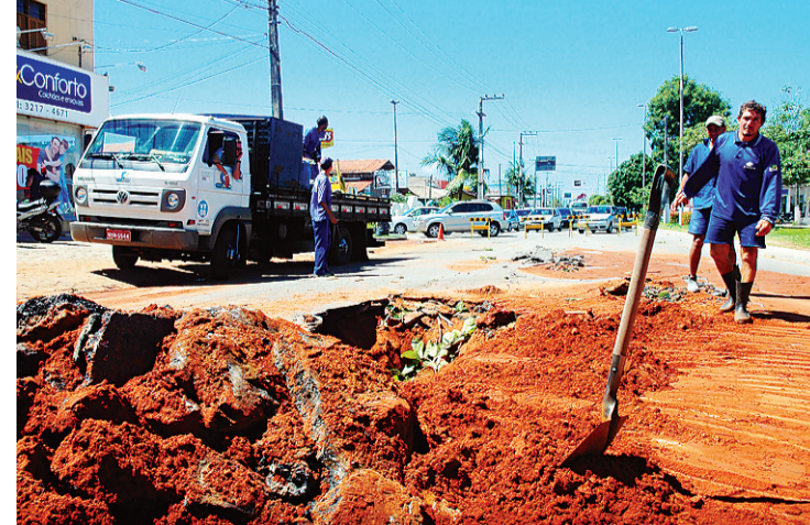
► Funcionários da Caern trabalham para consertar tubulação
