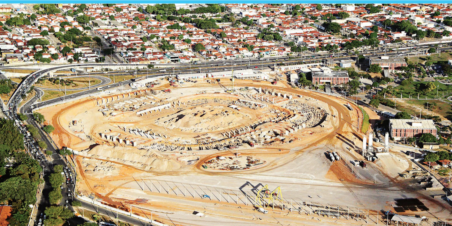
► Construção da Arena das Dunas está entre maiores investimentos em Natal
