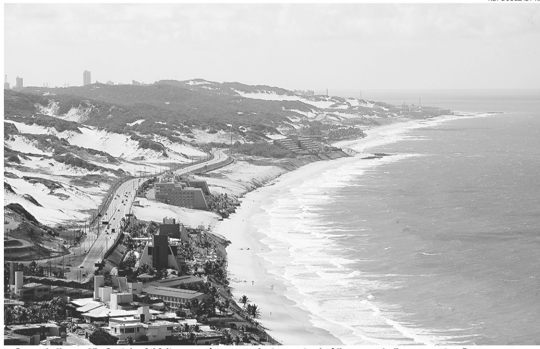
► Segundo Ibama, Via Costeira foi feita numa época sem instrumentos jurídicos para balizar a construção
