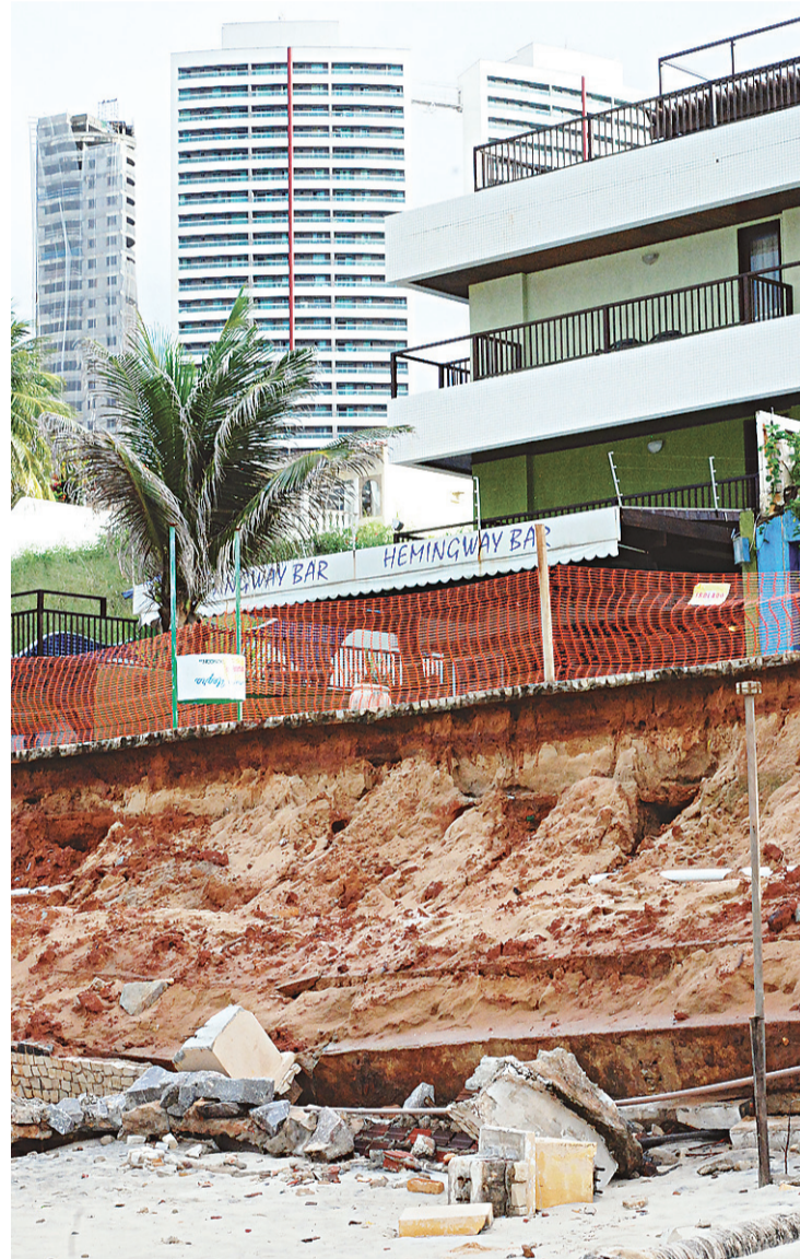
Em alguns casos, erosão está a poucos metros dos hotéis e bares
