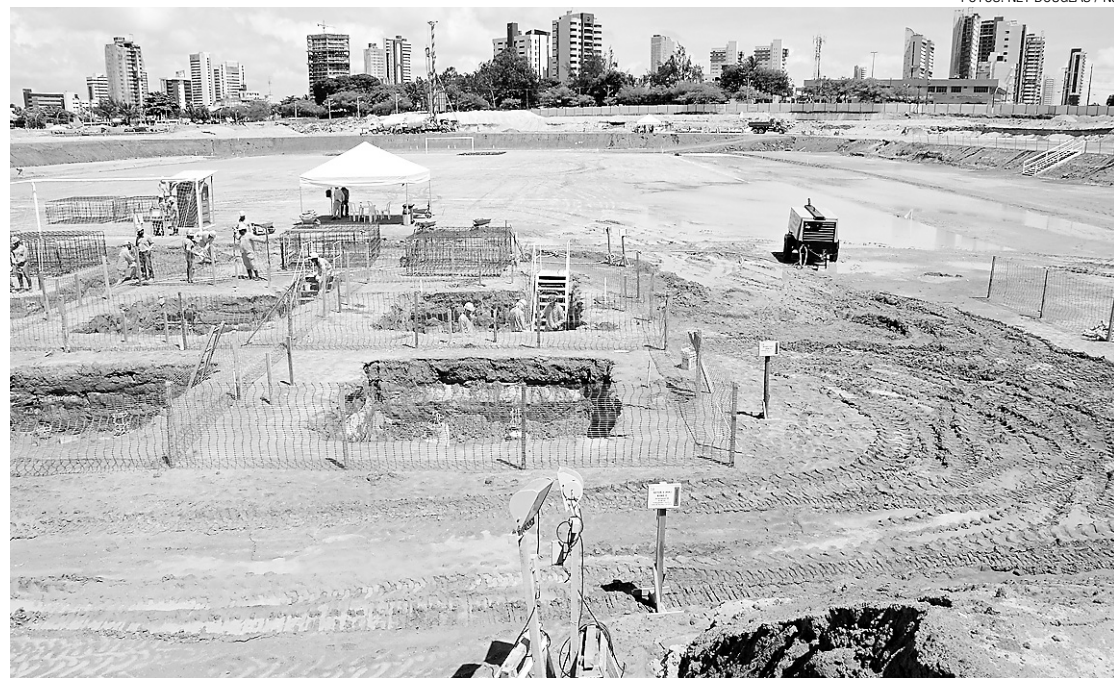
► Início da fase de blocos de coroamento, que estava prevista para março, começou ontem, garantindo o otimismo
