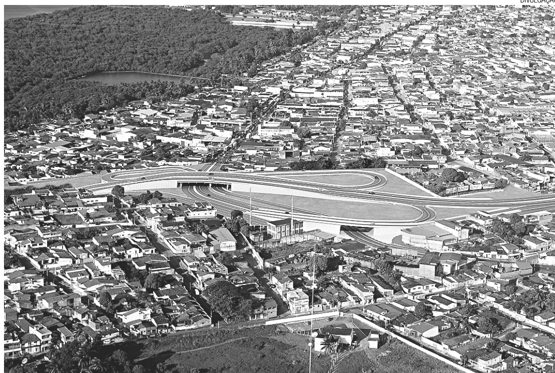
Montagem mostra como vai ficar a malha viária no lugar da Urbana, nas Quintas
