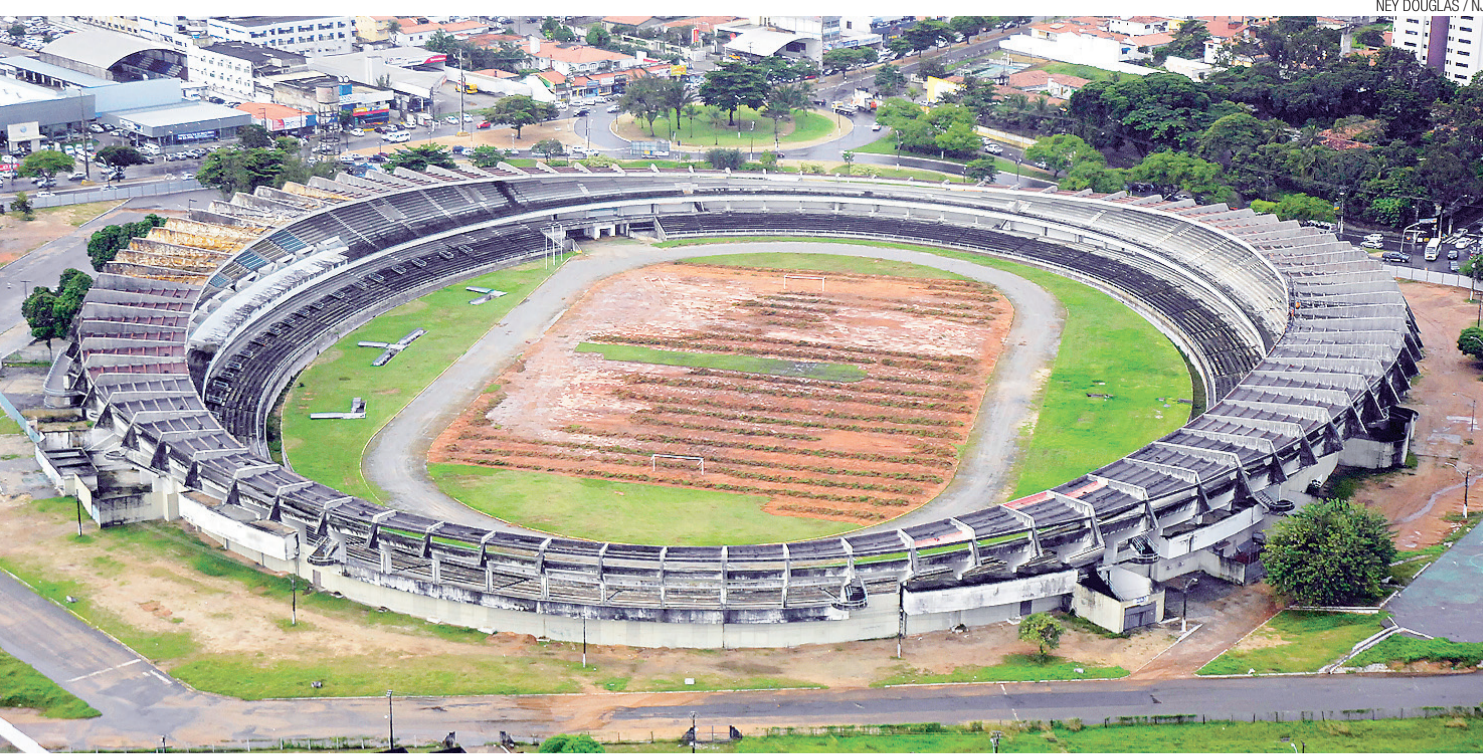
► Demolição do Machadão deixará times sem estádio para a disputa do Estadual no próximo ano
