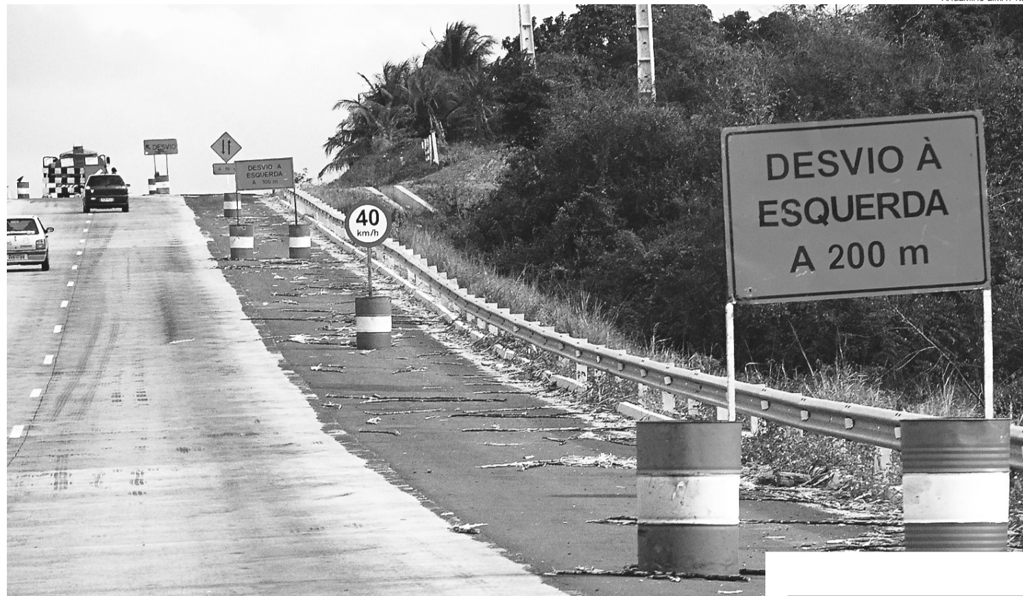
► Obras na BR-101 estão sob suspeita
