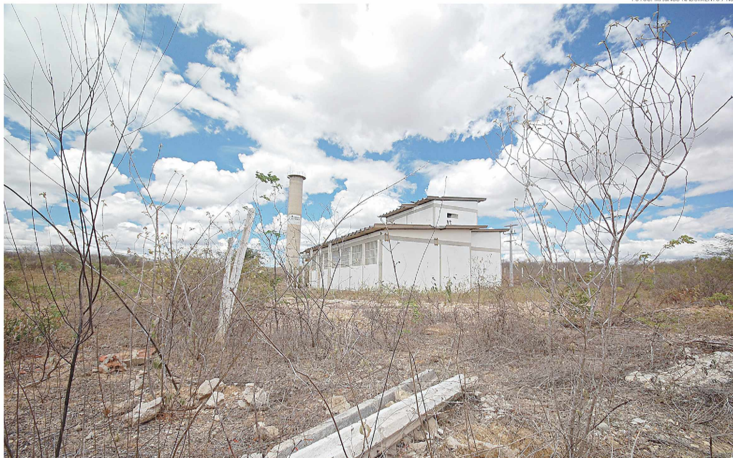
▶ Instalações estão abandonadas no DIBA
