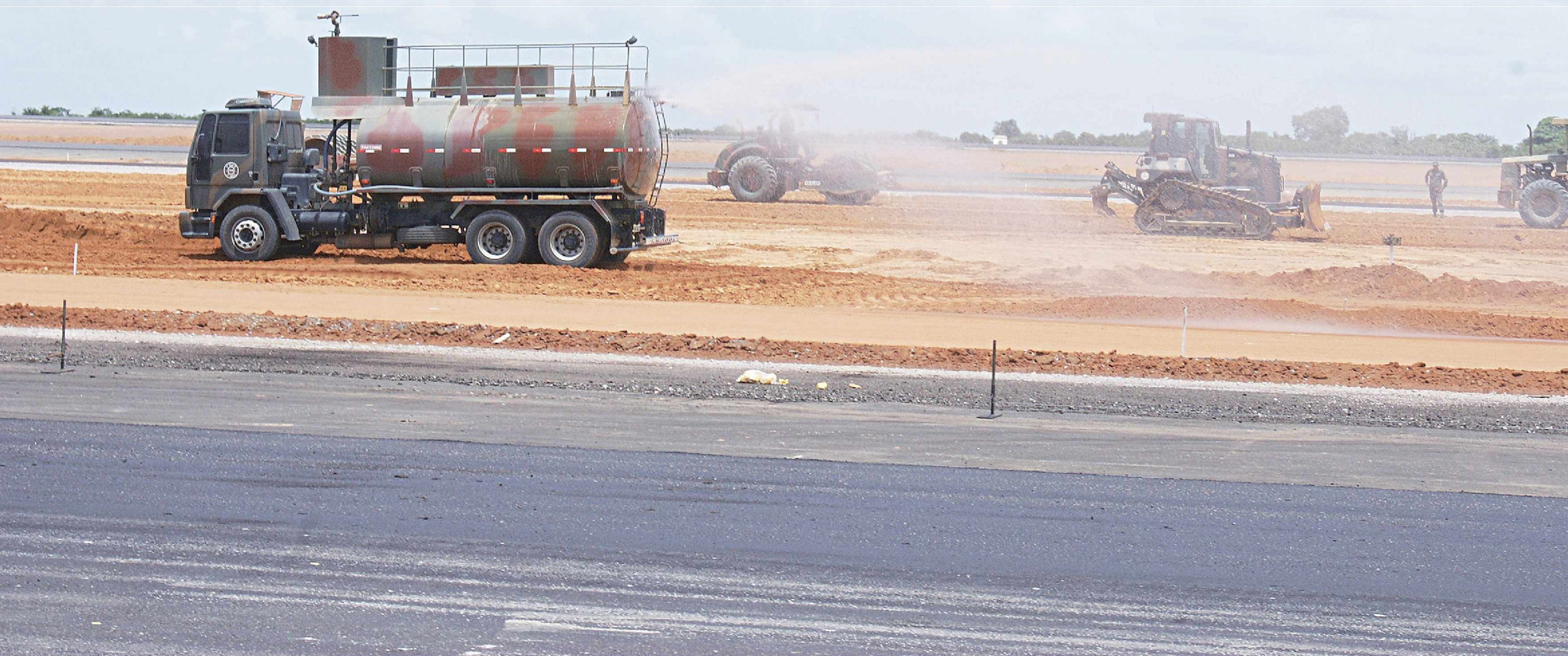
► Pistas do aeroporto estão sendo construídas pela Infraero
