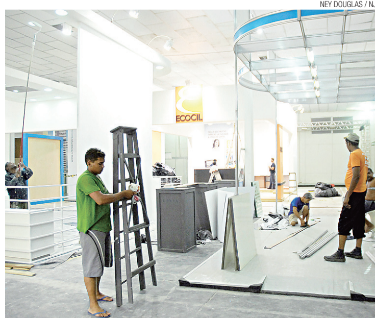
► Montagens de estandes são finalizadas
