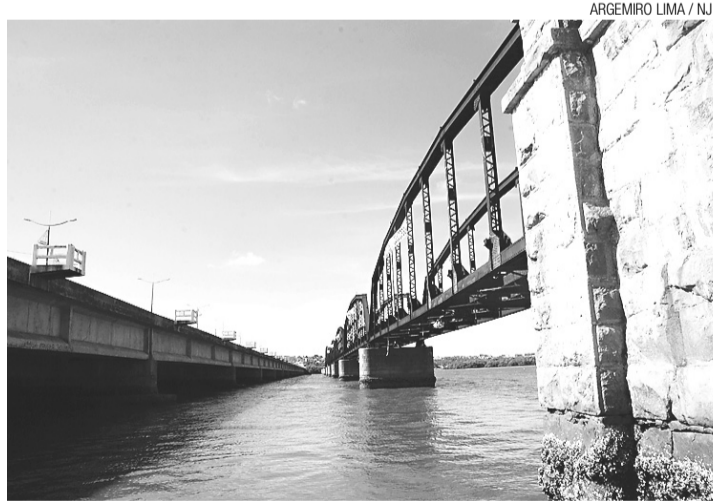
▶ Ponte de ferro foi desativa em 1970 com a inauguração da ponte de concreto
