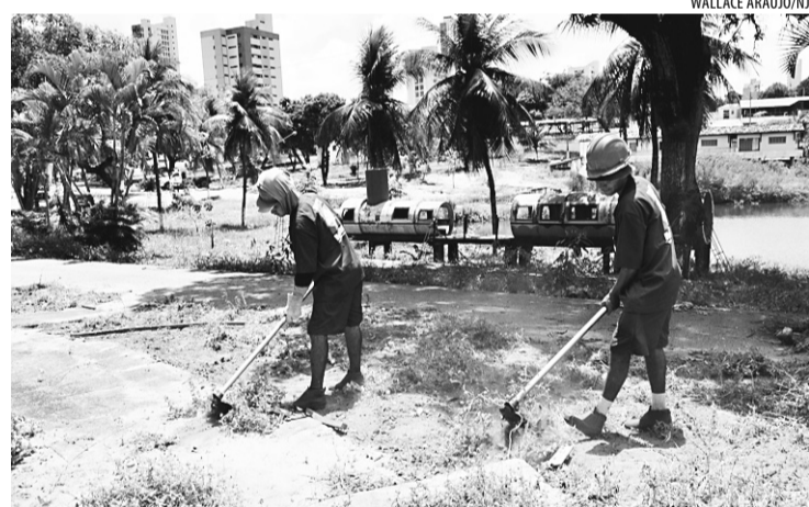
Reforma da Cidade da Criança (esq) e construção da Cidade da Ciência (dir) são obras recém iniciadas
